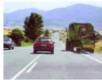
Marcas longitudinales continuas adosadas a discontinuas
